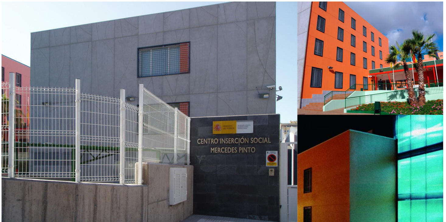
estructura de hormigón armado
